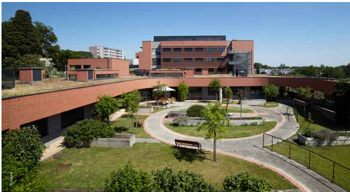
CHU de Toulouse – Hôpital Garonne – Démarche HQE
